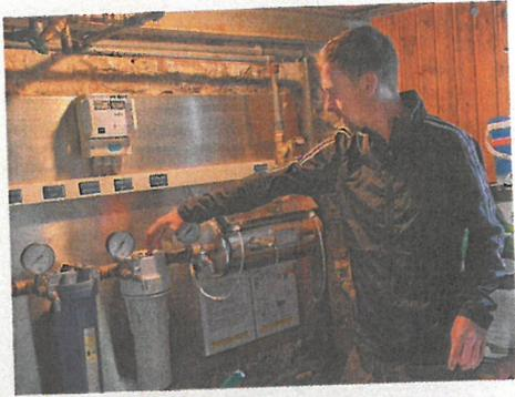
Im Karstgelände der Kalkalpen bezieht die DAV-Hütte ihr Wasser allein vom Dach. Es wird aufwändig aufbereitet und entkeimt. Regnet es wenig, sind die Tanks schnell leer.
